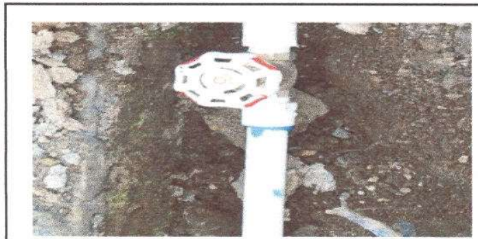
FOTO 9: Finalización de la instalación de dos llaves de paso
