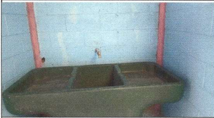
FOTO 13: Finalización de la sustitución de 3 llaves de chorros
