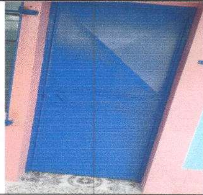
FOTO 14: Finalización de la sustitución de 2 chapas de puertas.
